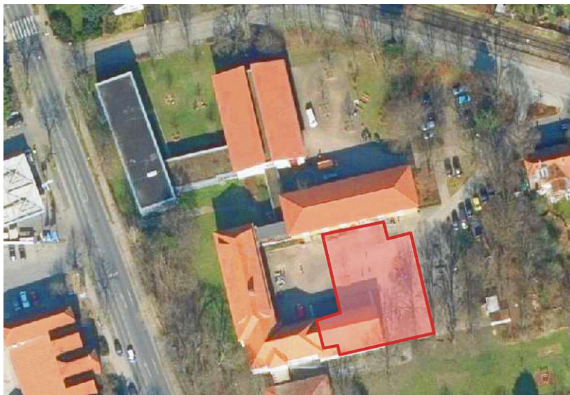
Während der Abriss- und Neubaurbeiten für die neue Mensa (rote Umrandung) der IGS Lengede auf dem Gelände der früheren Haupt- und Realschule wird eine Zeltmensa als Ersatz aufgestellt. Links die Lafferder Straße, oben die Straße An der Realschule und das Bahngleis.
