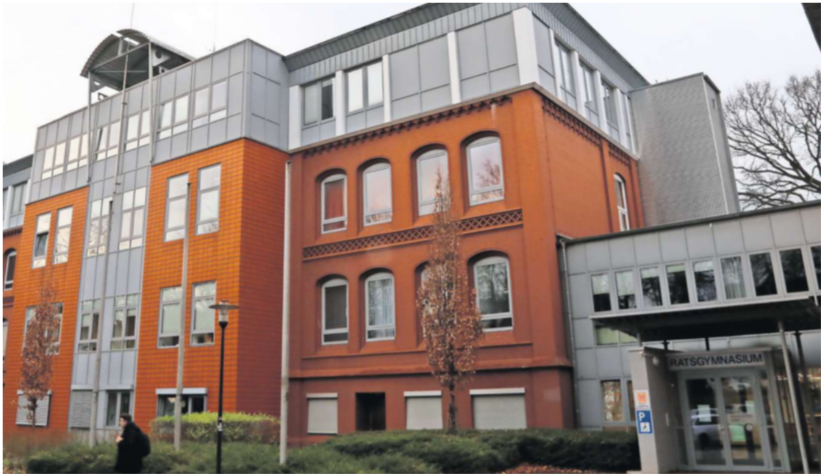
Ratsgymnasium Peine: Die Physikräume der Schule sollen saniert werden.
