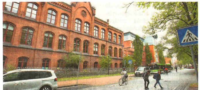
Der Burgschule in Peine fehlen noch Klassenräume: Deshalb möchte die Schule ausbauen.
