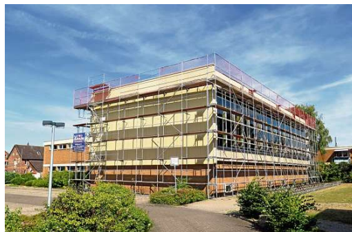
Für 100 000 Euro wird gegenwärtig das Dach des Hallenbades am Schulzentrum in Groß Ilsede saniert. Im Februar hatte ein Orkan Teile der Abdeckung weggerissen. FOTO: THOMAS STECHERT
