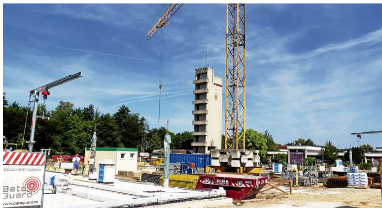
Das Kreishaus II an der Werner-Nordmeyer-Straße in Peine wächst - auch jetzt in den Sommerferien. Der Neubau für 13,5 Millionen Euro ist die derzeit größte Baustelle des Landkreises Peine. FOTO: THOMAS STECHERT
