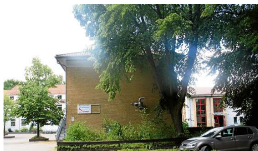
Die Klassen der Oberstufe der IGS Lengede werden in den Gebäuden der früheren Haupt- und Realschulen untergebracht (An der Realschule, Lengede). Weil der Platz nicht ausreicht, sollen noch Container aufgestellt werden. FOTO: ARNE GROHMANN
