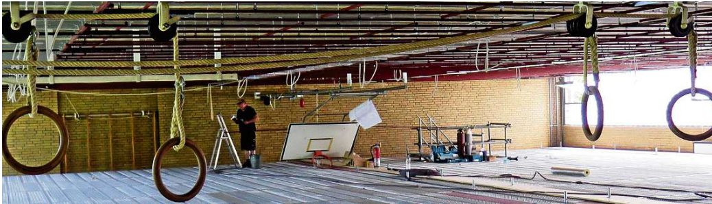
Ein riesiges Baugerüst teilt die Sporthalle des Peiner Ratsgymnasiums in zwei Ebenen. Mitarbeiter der Peiner Firma BauwerkeDM sanieren die Decke energetisch. Der Kreis investiert 865 000 Euro in die Schule – der größte Posten der Investitionen in die kreiseigenen Schulen in diesem Sommer. FOTO: STECHERT
