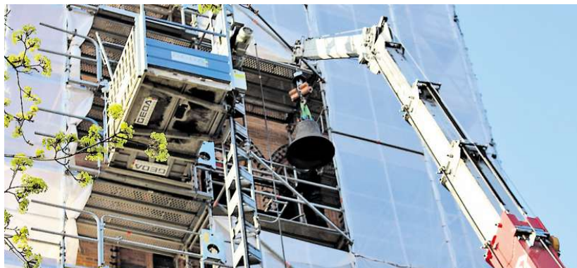
... und dann mit einem Kran wieder im Glockenturm eingesetzt.
